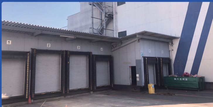
第一倉庫：延床面積 4,591 m 2 / 冷凍室 8 蔵
